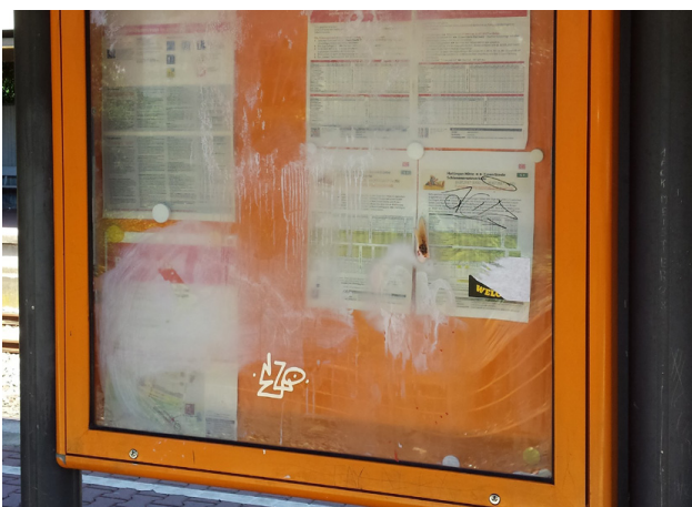
Station E-Steele Ost: Graffiti-Schaden von Station&Service beseitigt
