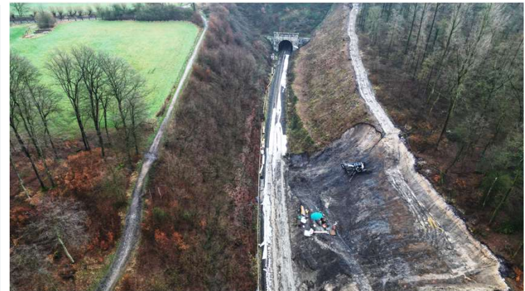
Überblick über den Hösel Tunnel
